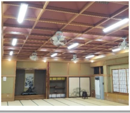
LED照明設置完了
