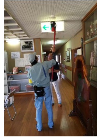
業者による点検の様子
