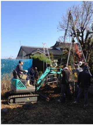
重機による井戸掘りの様子
