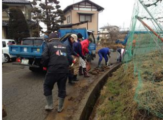
堆積土砂の除去作業の様子
