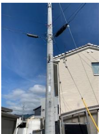
新たに設置した防犯灯
