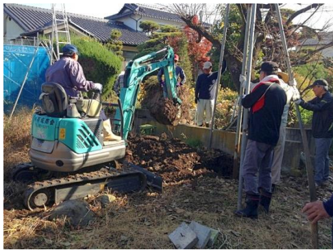
高澤様ご自宅裏での大規模な井戸掘り作業を行った
